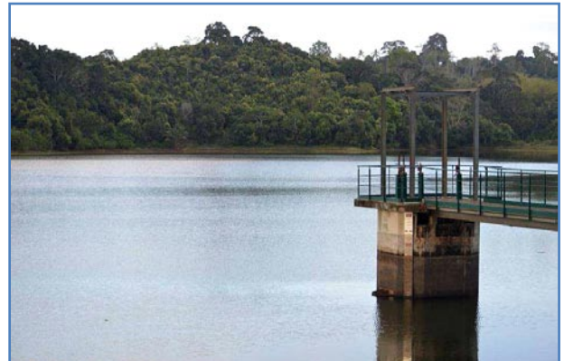
Figure 3 : Retenue collinaire de Dzoumogné (©GEPOMAY).
