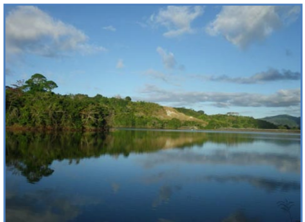
Figure 4 : Retenue collinaire de Dzoumogné (© GEPOMAY).
