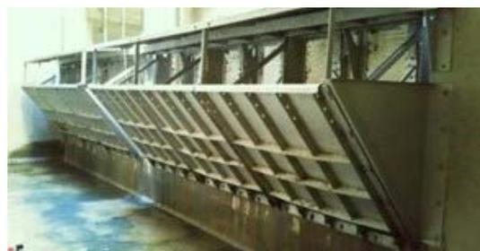
*Figure 16. Dégrilleur vertical. Source/crédit : Hydroconcept*
