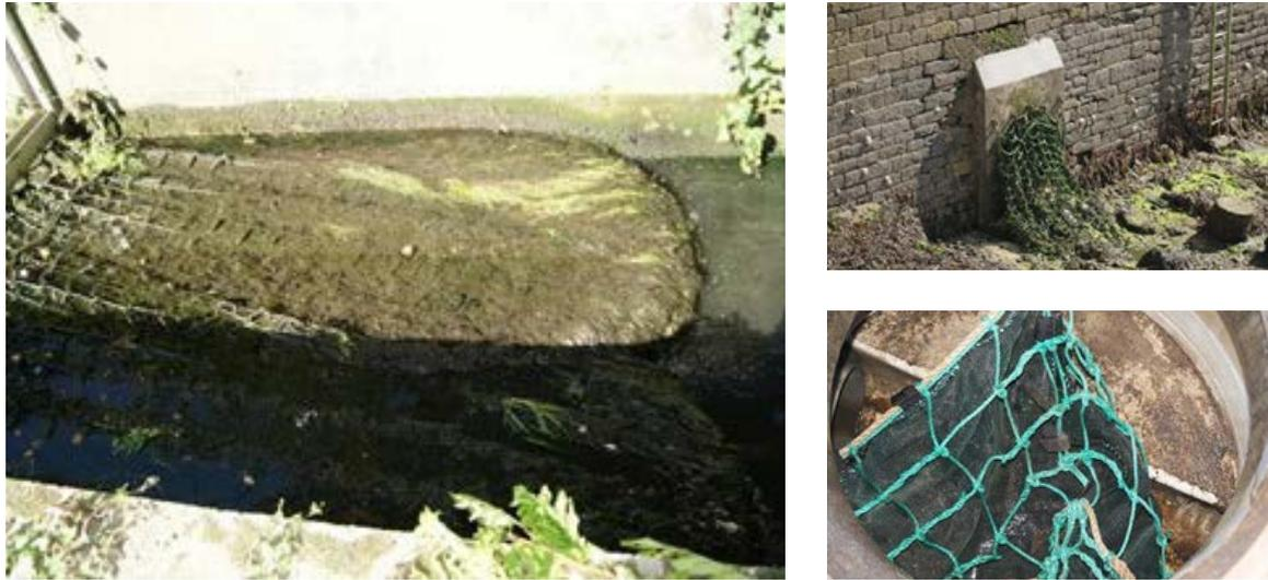
Figure 12. Filets de rétention en place sur Brest Métropole dans cours eau, sortie eau pluviale, et avaloirs (Photos OiEau)
