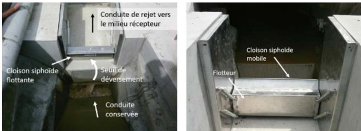
Figure 14. Exemple de cloison siphonide mobile pour retenir les déchets flottants (Source : HYDRASS-3D eau)
