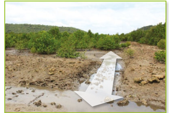
Figure 9 Exemple de réalisation d'une brèche dans une mangrove modifiée par l'humain, à l'aide d'une pelleteuse. Plus tard, cette opération autorisera la colonisation naturelle de la zone située à l'arrière de la levée topographique : 6 espèces différentes viendront s'y épanouir ! (source : Lewis & Brown, 2014)
